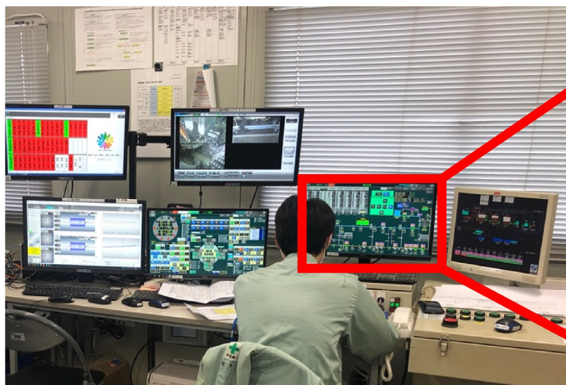
中央監視室での掘進管理 (発進基地（落合水再生センター内）)
