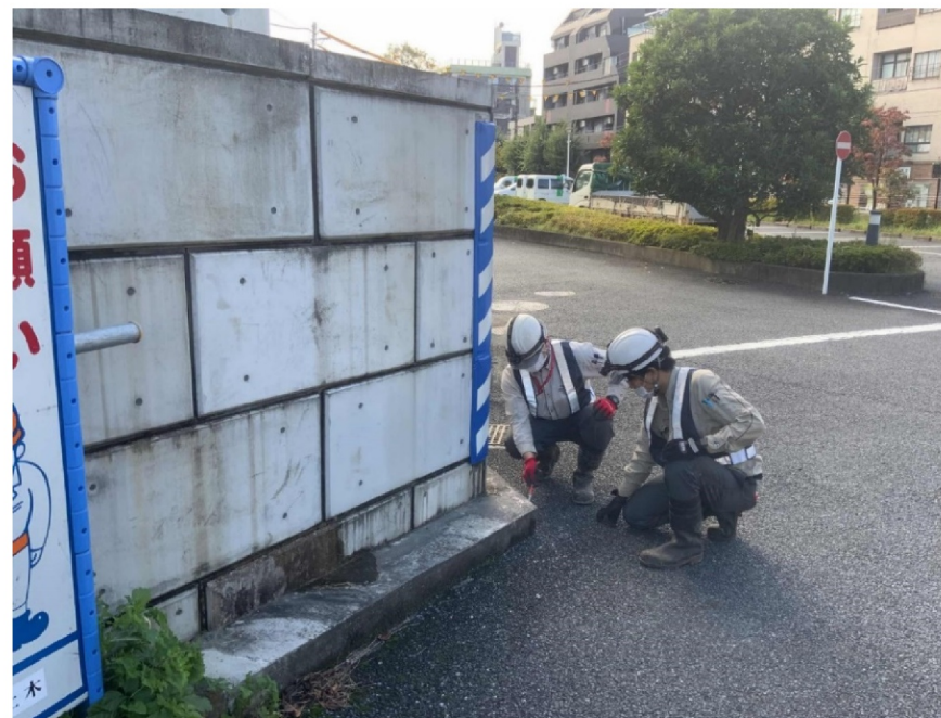
路面変状監視
