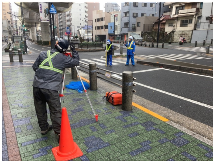
路面変状計測
